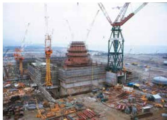
建設中の東海第二発電所（原電）
