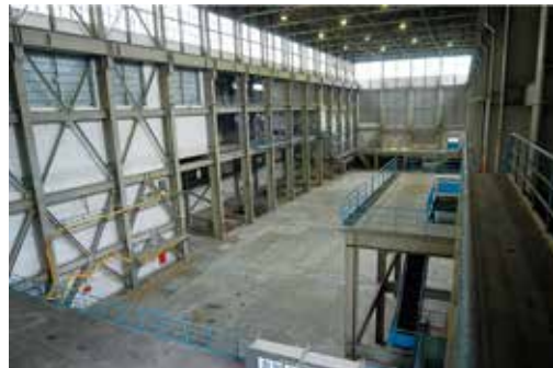
タービン発電機撤去後（2004年3月撮影）
