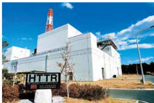
高温工学試験研究炉（HTTR）（機構大洗）
