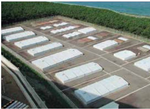
低レベル放射性廃棄物保管廃棄施設（機構原科研）
