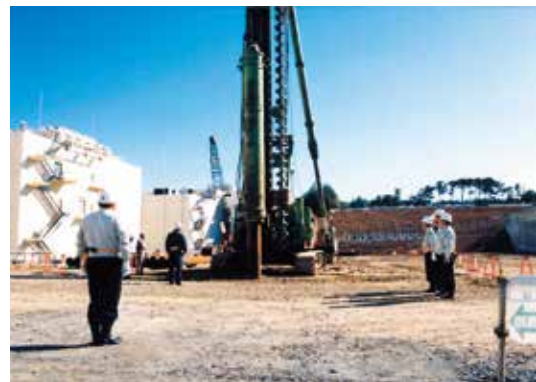
リサイクル機器試験施設(RETF)着工 (動燃東海)
