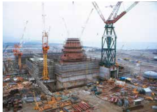
建設中の東海第二発電所（原電）
