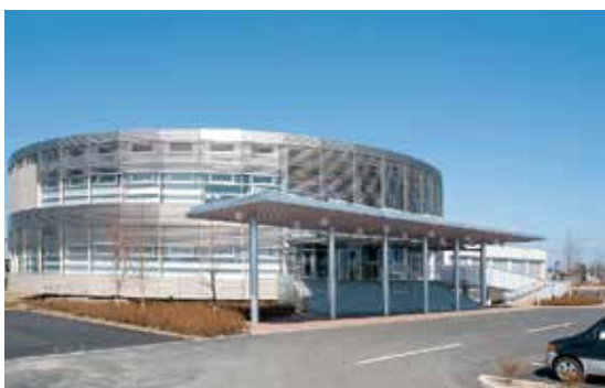
支援棟（原子力緊急時支援・研修センター）
