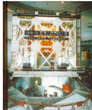
旧 J R R - 3 炉体一括搬出工事の様子
