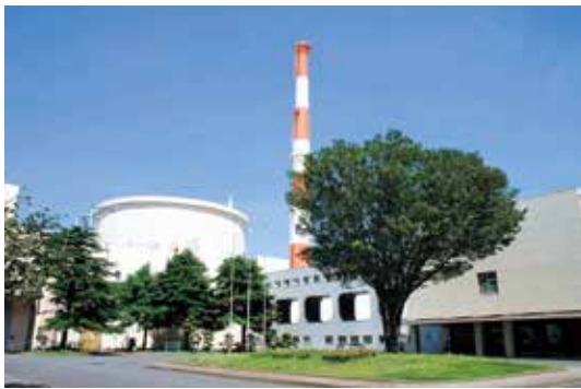
高速実験炉「常陽」（機構大洗）
