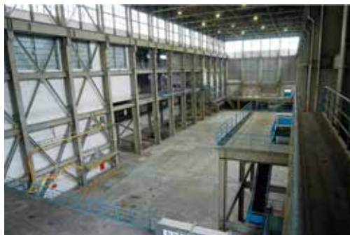
タービン発電機撤去後（2004年3月撮影）
