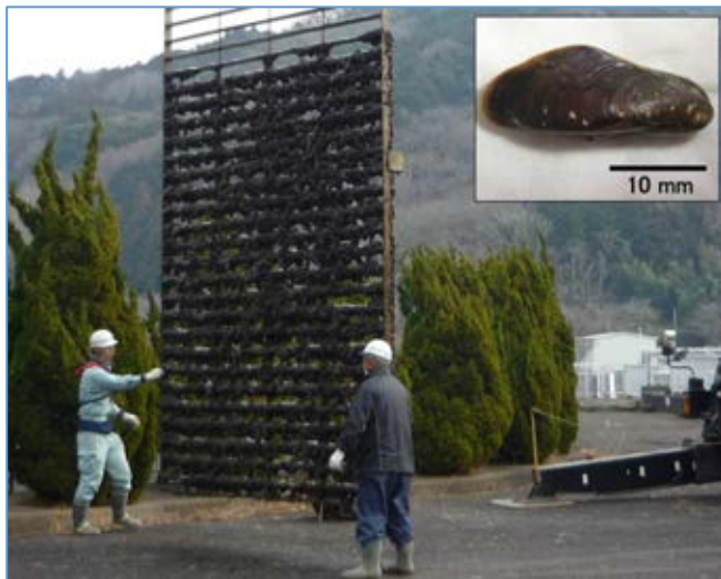
図 1 貯水池のバースクリーンに付着したカワヒバリガイ
