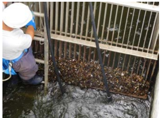
図4 バースクリーンの清掃状況
