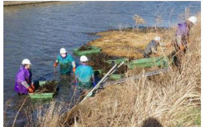
図9 新利根川における冬季の除去作業の様子 (2018年2月14日)
