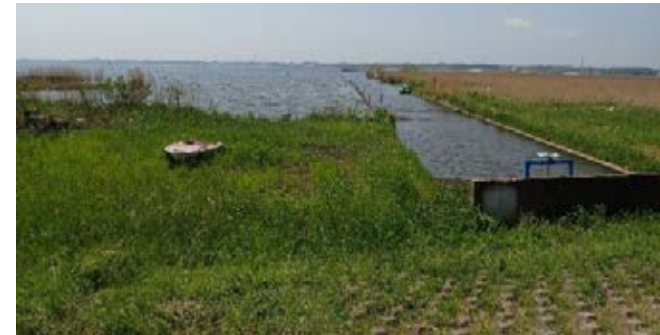
写真8 防除後の排水路左岸 (2018年4月)
