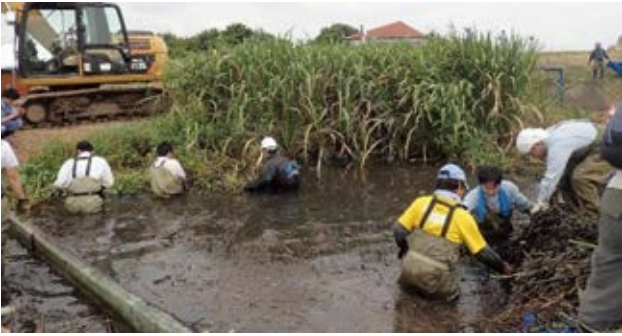
写真3 排水路内の防除の様子 (2017年8月)
