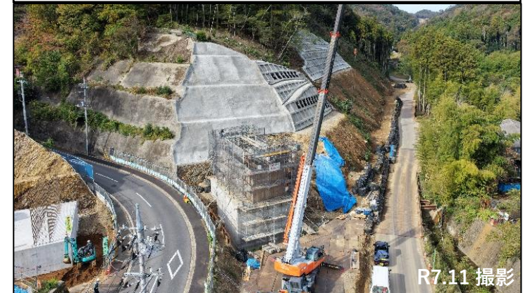
①（仮称）第2号橋下部工及び法面工
