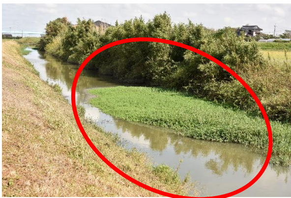
◎ 水路を塞ぐほど繁茂した状況
