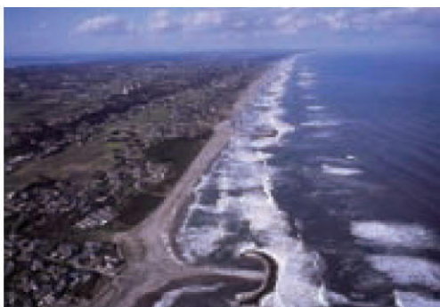
鹿島灘に整備したヘッドランド
