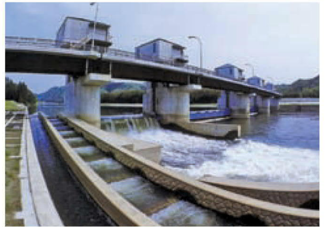
久慈川の農業用取水堰に併設した魚道
