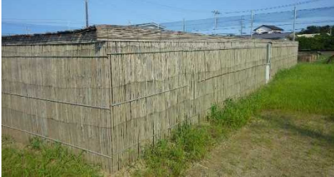
竹す施設の外観 (屋根は平らで全体的に四角形)
