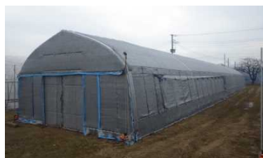
雨よけ施設 (アーチ型パイプハウス)
