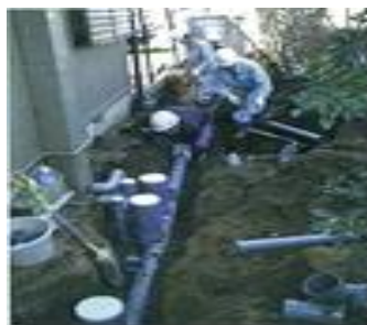
下水道接続工事
