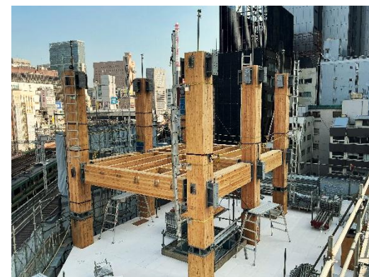
県産木材による木造ビルの建築
