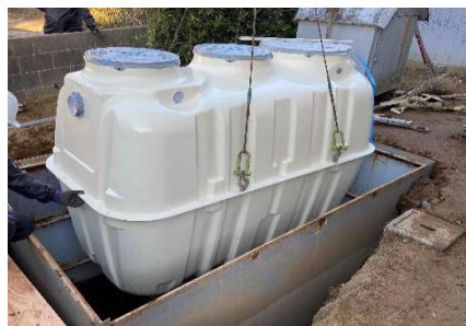
高度処理型浄化槽の設置
