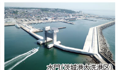
防潮堤(鹿嶋海岸(目川))
