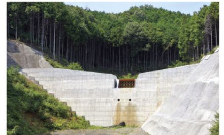
田尻沢(砂防堰堤)
