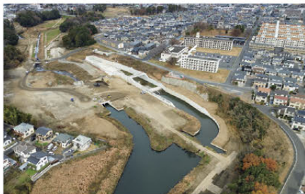
中丸川(調節池整備)
