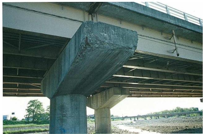
写真 2.5.6 凍害による損傷事例
