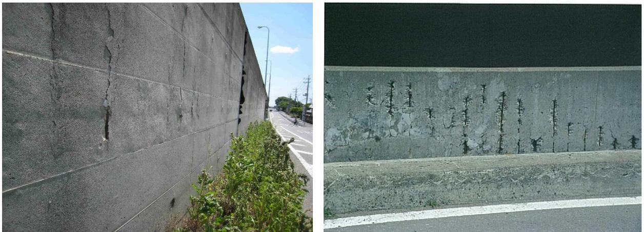
写真 2.5.3 中性化による損傷事例
