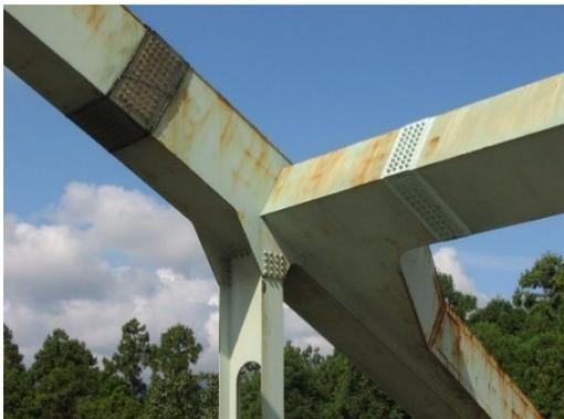
写真 2.4.1 桁ウェブに設けた落下防止ネット
