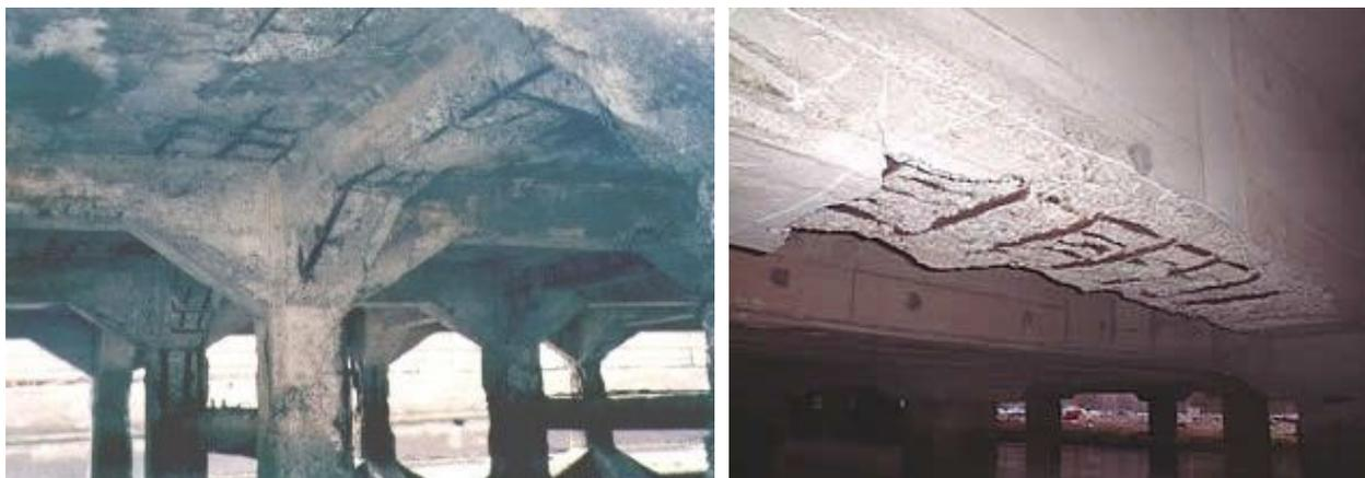
写真 2.5.4 塩害による損傷事例
