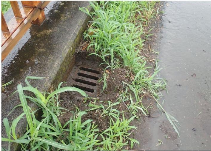
写真 1.4.3 排水工の土砂だまりの例
