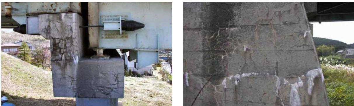
写真 2.5.5 ASR による損傷事例
