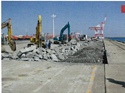
◎岸壁の応急復旧状況(震災1週間後)
