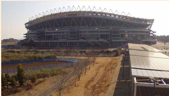
カシマサッカースタジアム 太陽光(100kW)蓄電池(100kWh)
