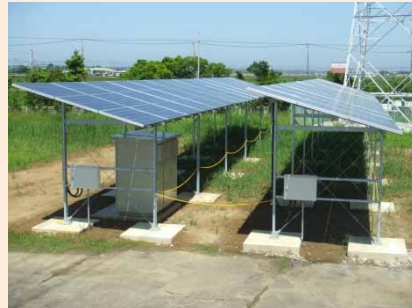
常陸大宮土木事務所 太陽光(20kW)蓄電池(15kWh)
