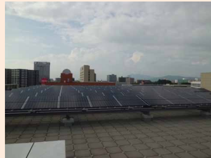
つくば国際会議場 太陽光(60kW)蓄電池(50kWh)
