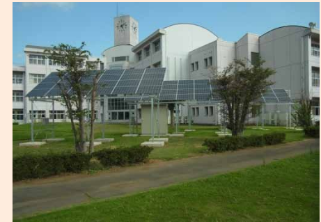
中央高等学校 太陽光(15kW)蓄電池(15kWh)
