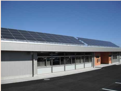
常陸大宮土木事務所 太陽光(20kW)蓄電池(15kWh)
