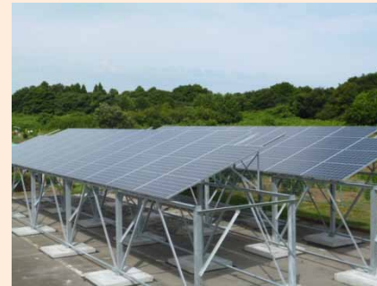
白浜少年自然の家 太陽光(20kW)蓄電池(15kWh)
