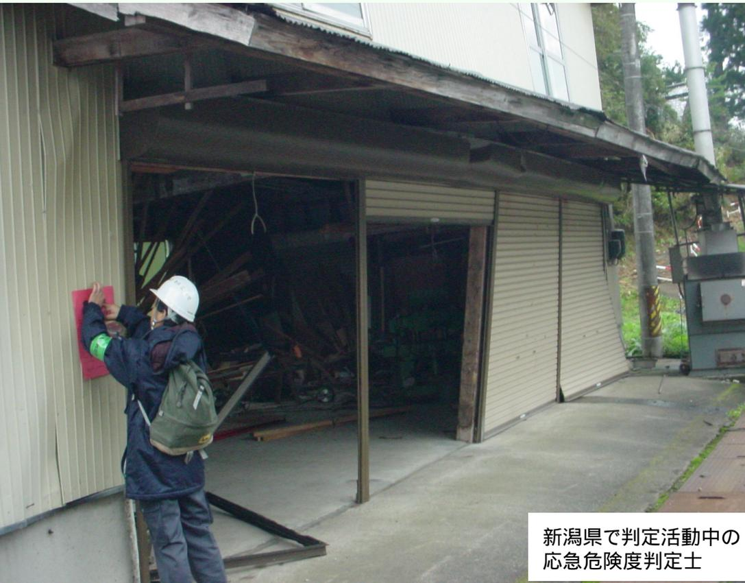
応急危険度判定とは、大地震で被災した建築物を調査し、その後の余震による倒壊の危険性や外壁・窓ガラスの落下、看板・塀の転倒などの危険性を判定するものです。
