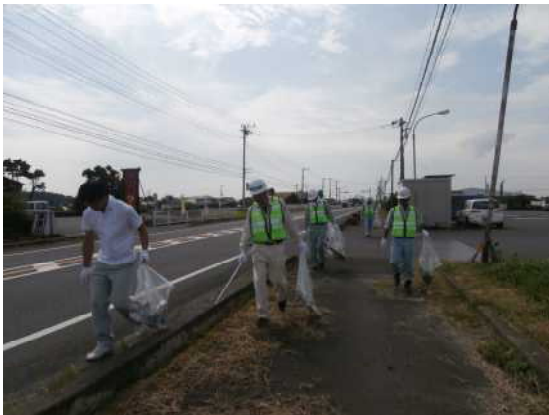
国道293号での作業状況
