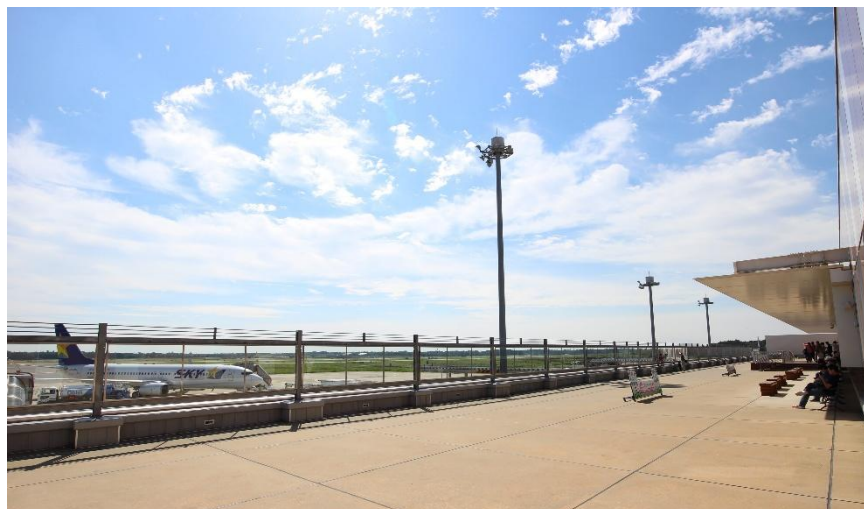
ターミナルビル（送迎デッキ）
