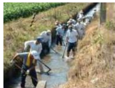
水路の泥上げ
