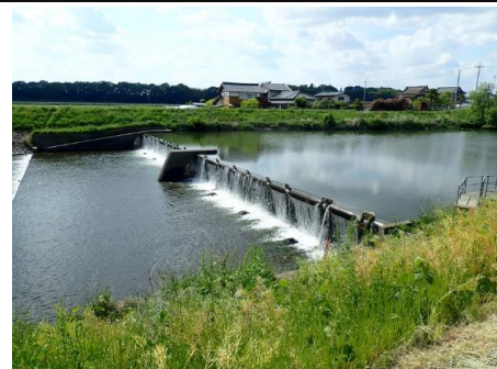
ため池等整備事業（河川応急） 赤井戸堰地区
