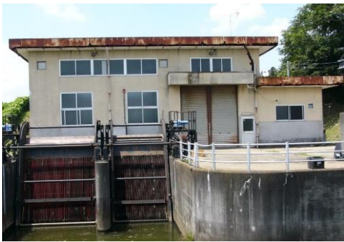
小谷沼第2 排水機場地区 (常総市) H25~R1
