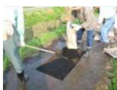
農道の部分補修
