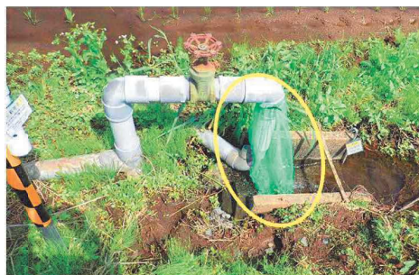
給水栓の口に収穫ネットを被せ流入を防止
