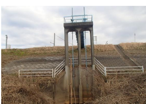
新堀揚水機場地区 (下妻市) H28~R1
