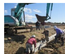
コンクリート水路の布設
