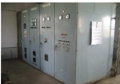
河内第6 機場地区 (河内町) H25~H30
