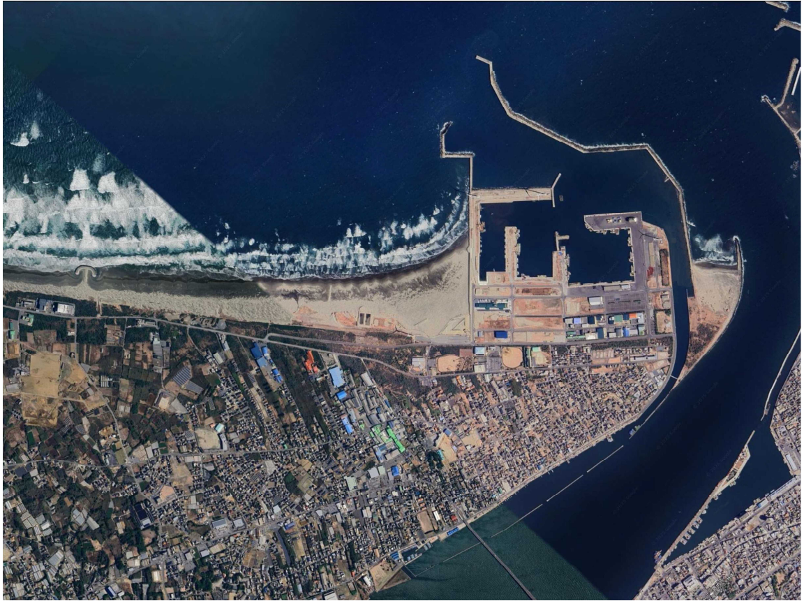
波崎漁港全景
