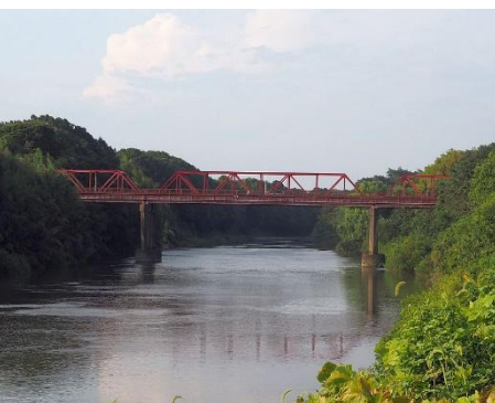
守谷市板戸井の河道開削部
