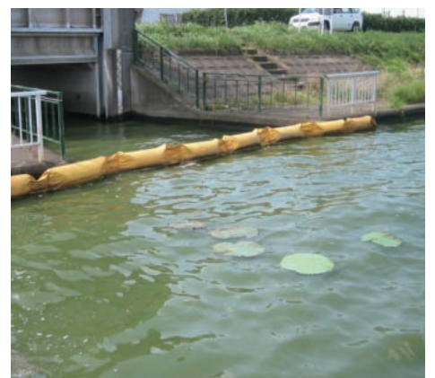
フェンスの設置
