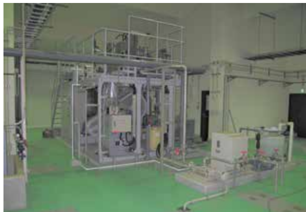
行方市玉造北部地区浄化センター（内部）
