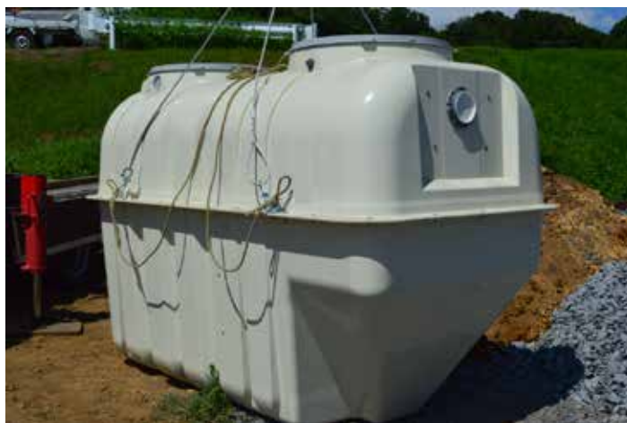
高度処理型浄化槽
