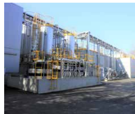
排水処理施設
