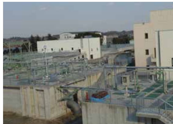
霞ヶ浦湖北流域下水道霞ヶ浦浄化センター
