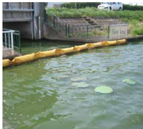
フェンスの設置
