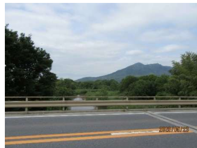
（巡見橋から上流を望む）
