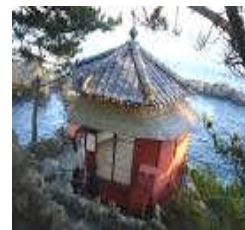
再建された六角堂
