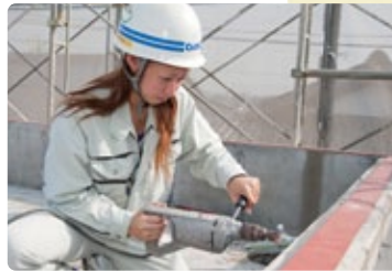
外壁工事の現場で建築機械を操作する杉森さん。
