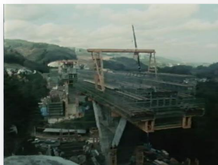
常磐自動車道建設工事
