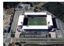
改修前の 県立カシマサッカースタジアム
