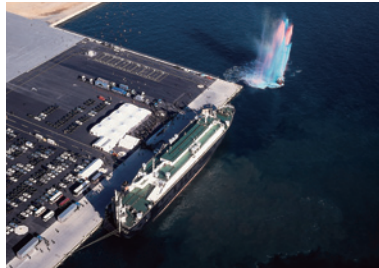
1998(平成10)年 常陸那珂港供用開始
