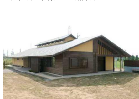
神栖総合公園管理事務所新築工事
