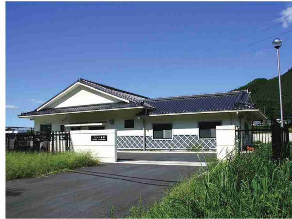
常陸太田市里見南部農業集落排水処理施設
