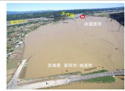
那珂川における浸水被害状況
