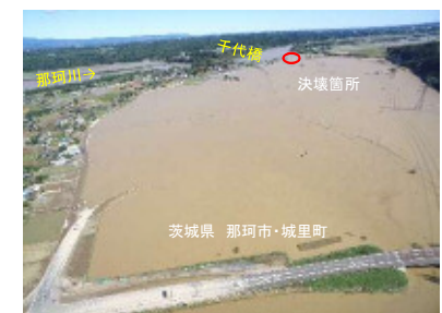
那珂川における浸水被害状況
