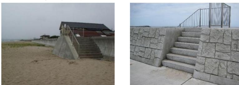
写真 3.10 乗り越しタイプ階段の整備例
