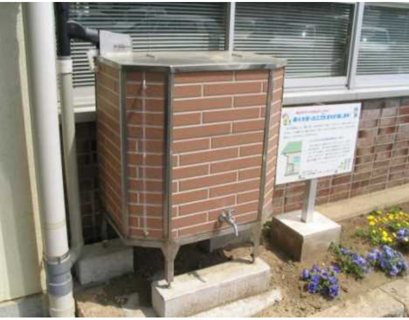
雨水貯留槽の設置イメージ
