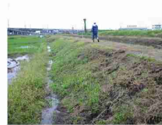
写真-2-1 洪水時の河川巡視点検状況（女沼川）
