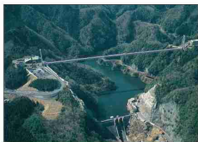
14 竜神ダム、竜神大吊橋
