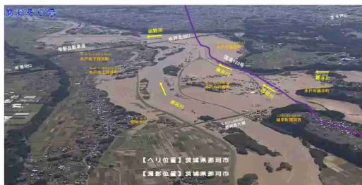
23 写真 1-3 令和元年東日本台風時の浸水状況 (国交省へり撮影)
