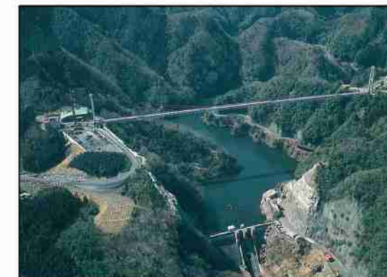
竜神ダム、竜神大吊橋
