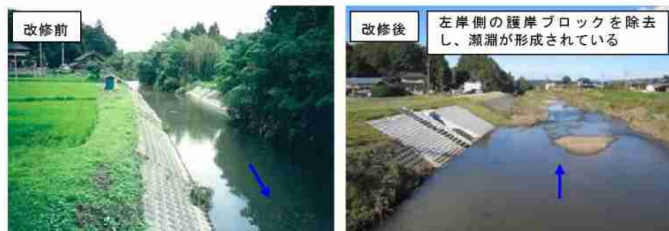
自然環境の保全・回復に配慮した浅川の改修例（善光寺橋付近）
