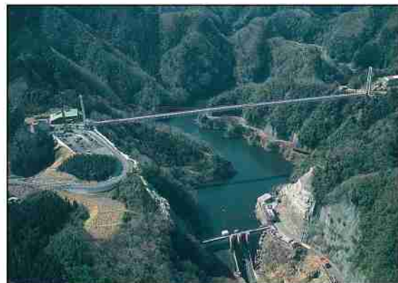
竜神ダム、竜神大吊橋
