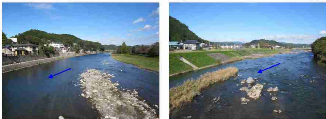
現況河床を残した久慈川の河道改修例（左：松沼橋付近、右：久慈川橋付近）
