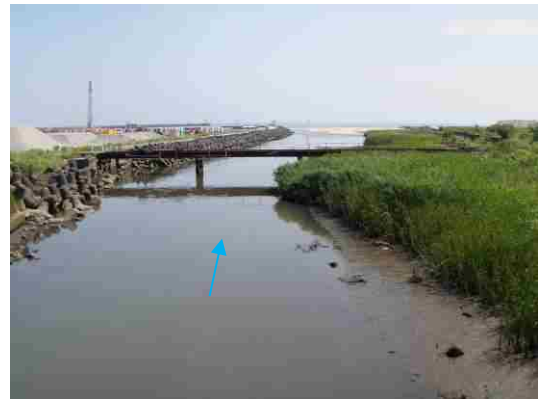
河口部（関南新橋下流）
