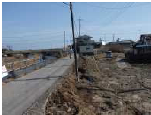
写真 1-5 東北地方太平洋沖地震による津波被害の状況（平成 23 年 3 月）
