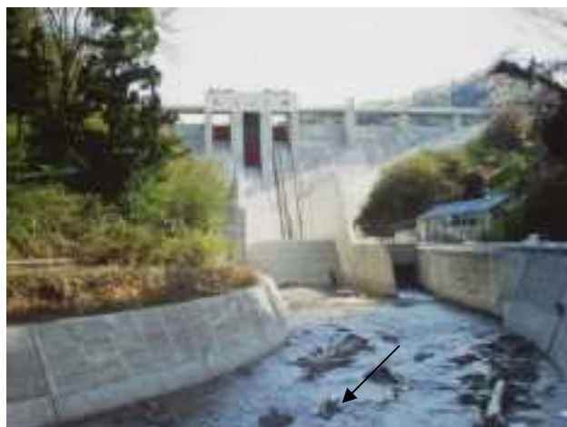
写真 2-3 十王ダム直下の状況 [5.5km 付近]
