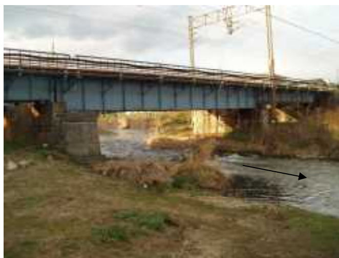
写真 2-1 JR 常磐線橋梁 [2.8 km 付近]
