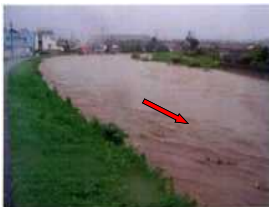
写真 1-4 洪水時の状況（平成 19 年 7 月洪水）〔0.2 km 付近〕
