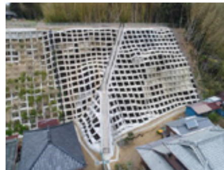
▲ 急傾斜地崩壊防止対策(龍ヶ崎市: 宮下)
