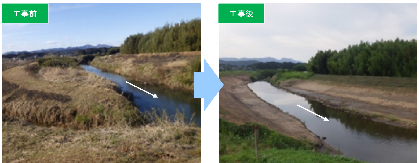
▲一級河川 恋瀬川の河川改修工事（石岡市、茨城県施工）
