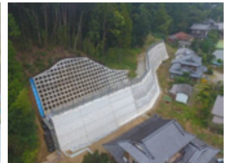
▲ 急傾斜地崩壊防止対策(行方市: 山田)
