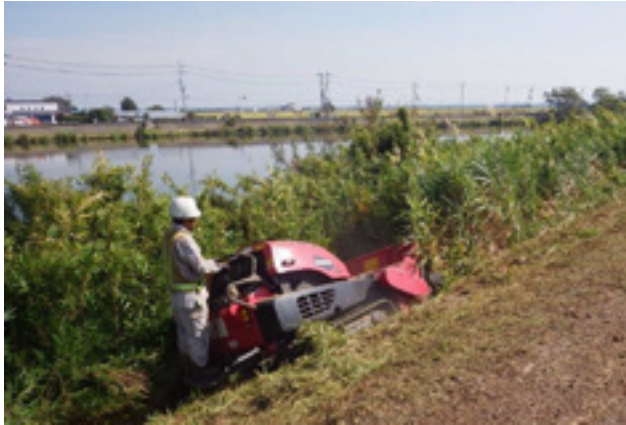
▲除草作業の様子(稲敷市:新利根川)
