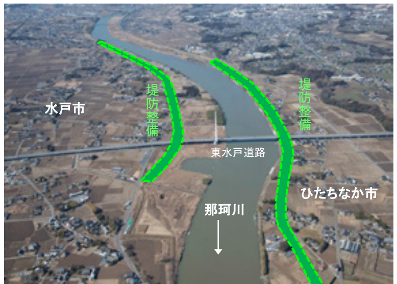
一級河川 那珂川の河川改修工事 (水戸市・ひたちなか市、国土交通省施工) ▶
