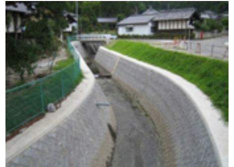
▲ 土石流対策(石岡市: 中戸沢)
