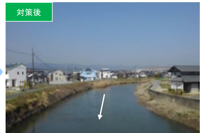
▲堆積土砂の撤去により、流下能力が向上(日立市:十王川)
