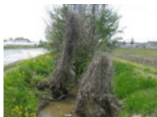
▲出水期前点検(樹木の繁茂)
