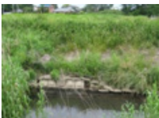
▲出水期前点検(堤防・護岸)
