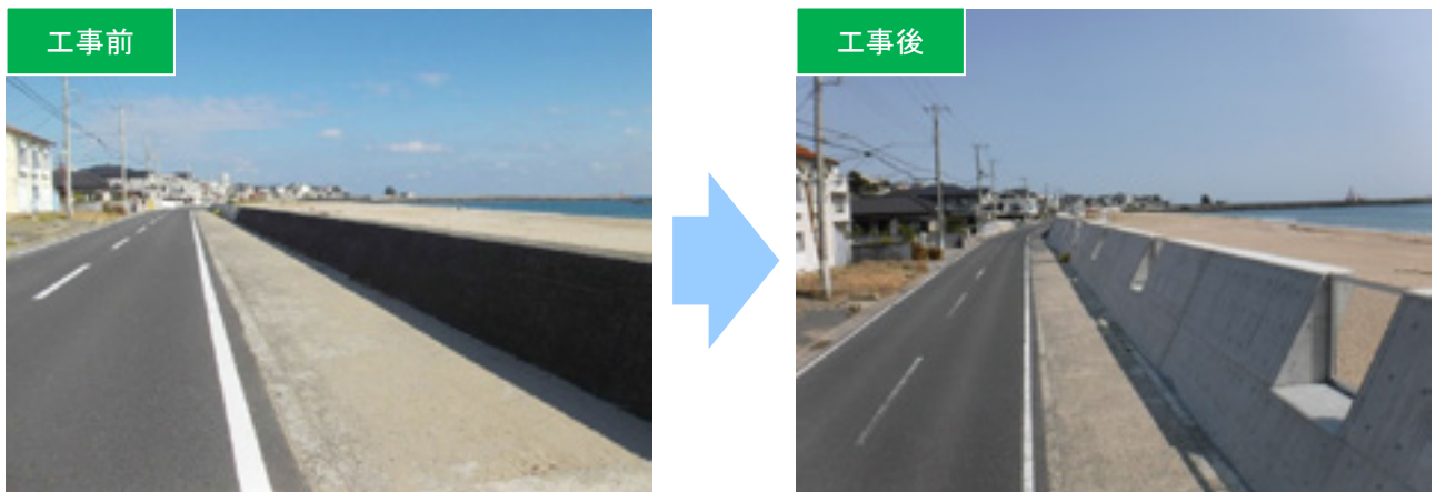
▲金沢海岸(日立市、茨城県施工)
