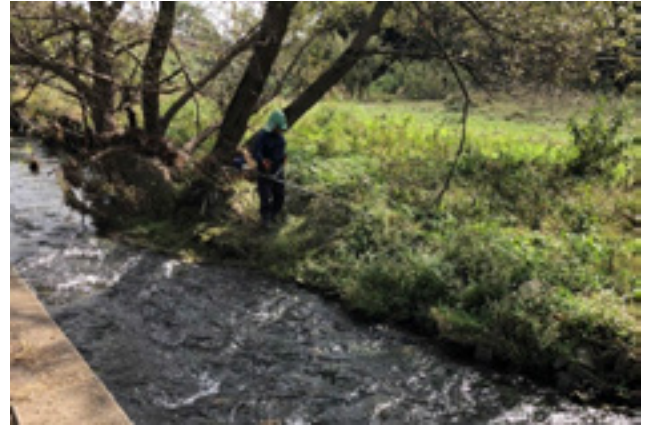
▲除草作業の様子(水戸市:沢渡川)
