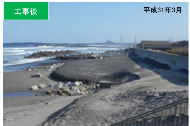
▲粗粒材養浜により砂浜が回復した神向寺海岸(鹿嶋市、茨城県施工)
