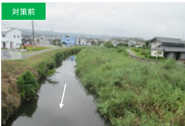
▲堆積土砂の撤去により、流下能力が向上(日立市:十王川)
