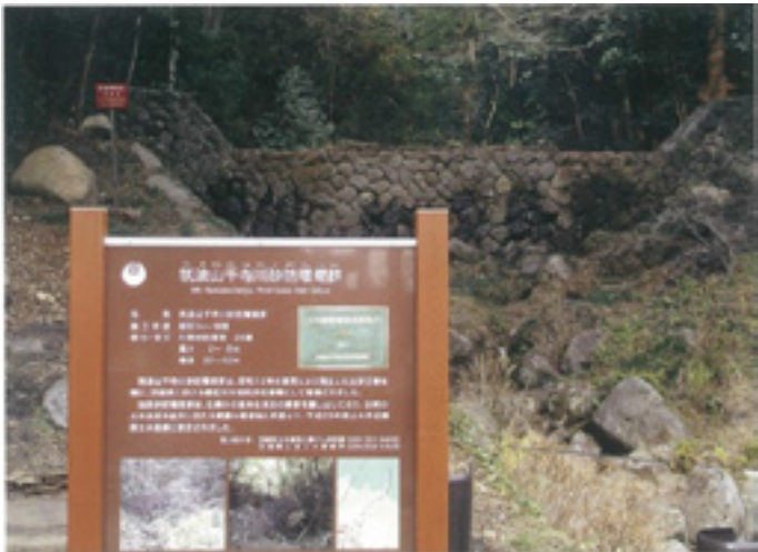
▲筑波山千寺川砂防堰堤群 ※茨城県における最初の本格的砂防事業として整備された箇所
