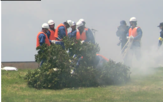
木に土のうを付け、川の中に流すことにより堤防に当たる流れの勢いを弱めて洗掘を防止する。
