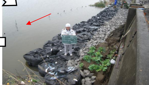
応急復旧後 (大型土のう設置工)
