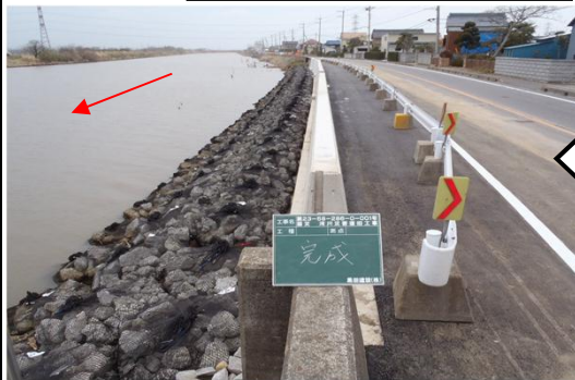
完成写真(本復旧完了)
