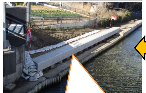
完成写真(復旧完了)
