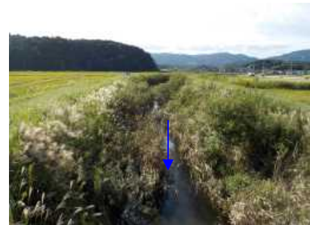
下流区間（新橋上流）
