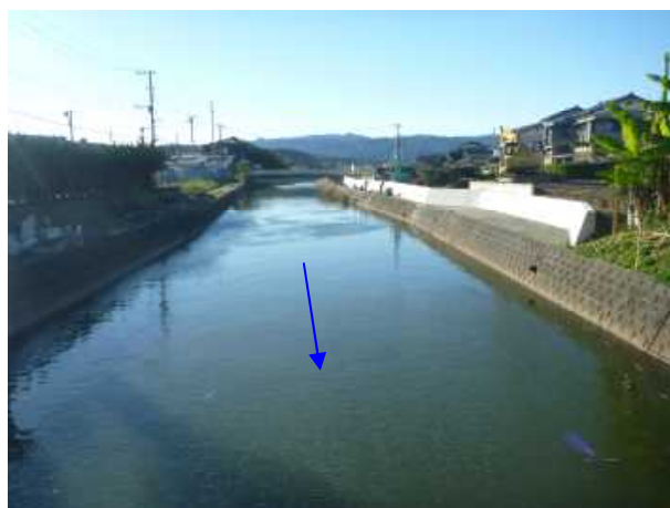
河口から 0.40km 付近
