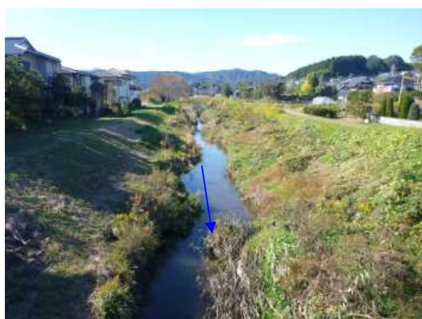
河口から 1.56km 付近
