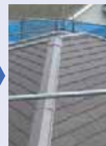
軽い屋根材への葺き替え
