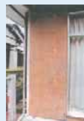
外壁側から筋かいや構造用合板により補強(外壁仕上工事費を含む)
