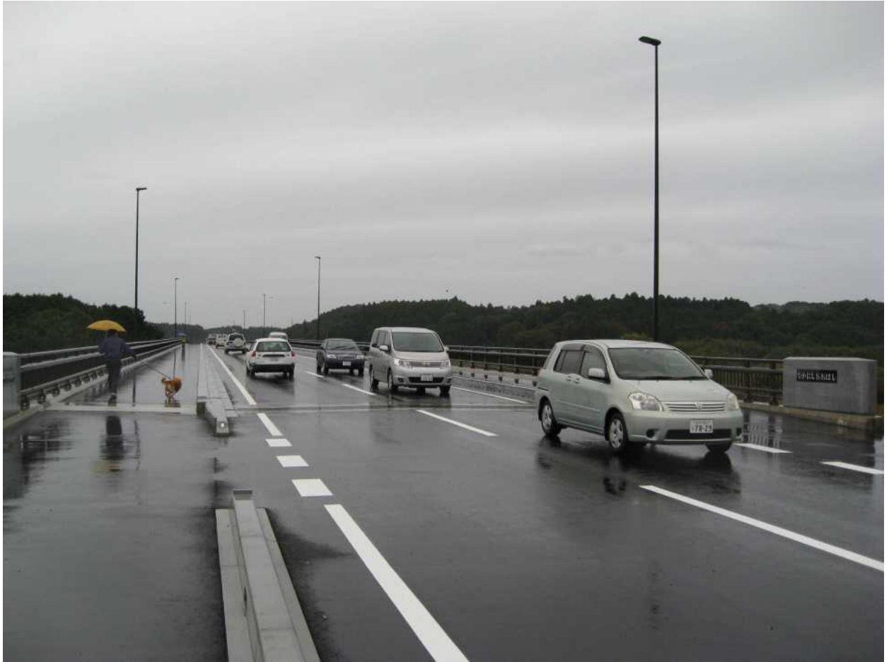
写真3 供用開始後の状況
