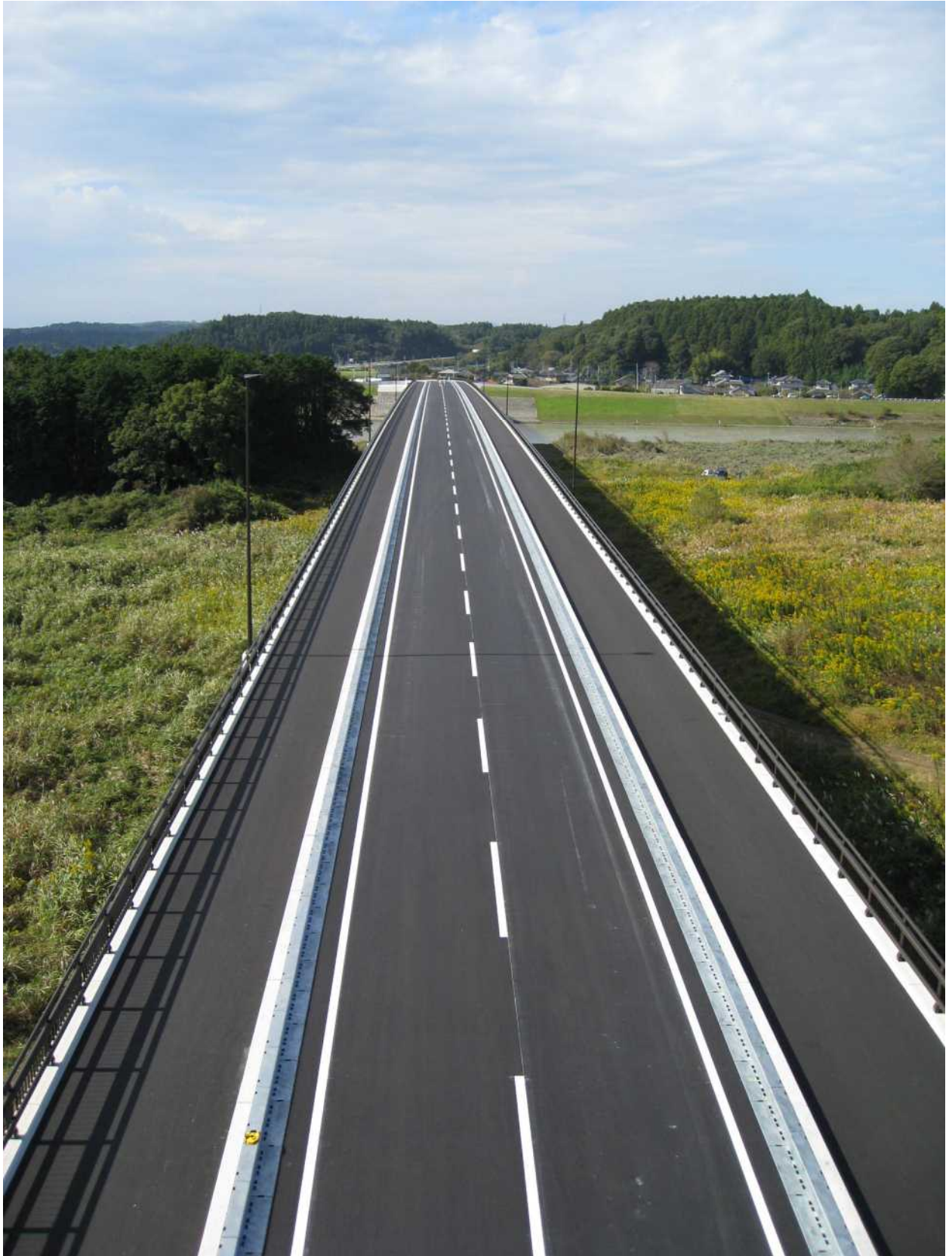
写真5 那珂西大橋（那珂市より水戸市・城里町方面を望む）
