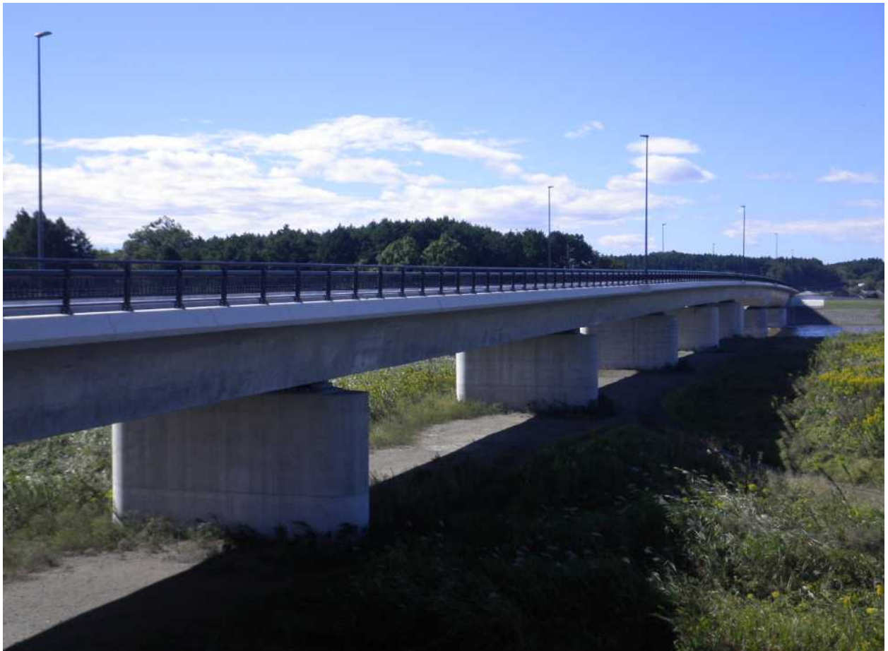
写真4 那珂西大橋（那珂市より水戸市・城里町方面を望む）
