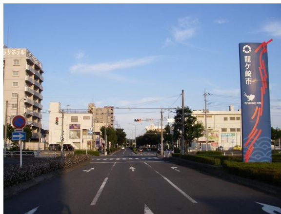
写真 2-5 佐貫駅前広場には水面から空に飛び立つ龍がデザイン化されたシンボルサインが整備されている
