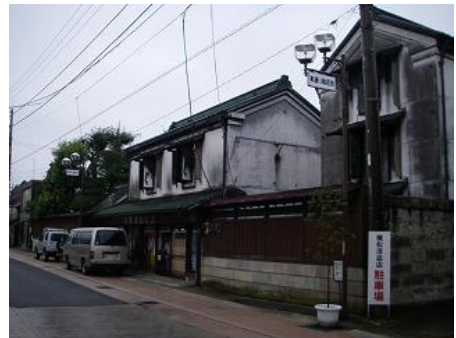
写真 3-61 蔵造りの商店。平入りの店蔵と妻入りの袖蔵が対となっている
