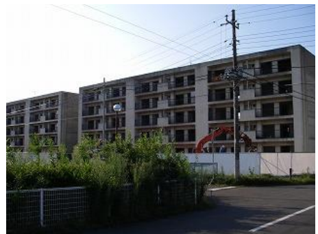
写真 3-68 旧社宅の取り壊しが進む
