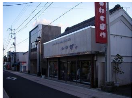
写真 3-63 現代的な建物のように見えても、脇から見ると歴史的な建築物であることがわかる。パラペットを撤去することで歴史的な街並みとなる
