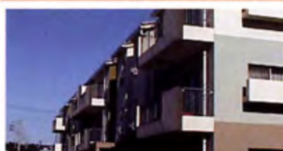
県営関本アパート
