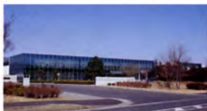
トステム株式会社土浦工場
